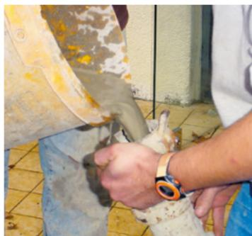
**La barbotine doit être récupérée à la sortie des tuyaux et jetée.**
