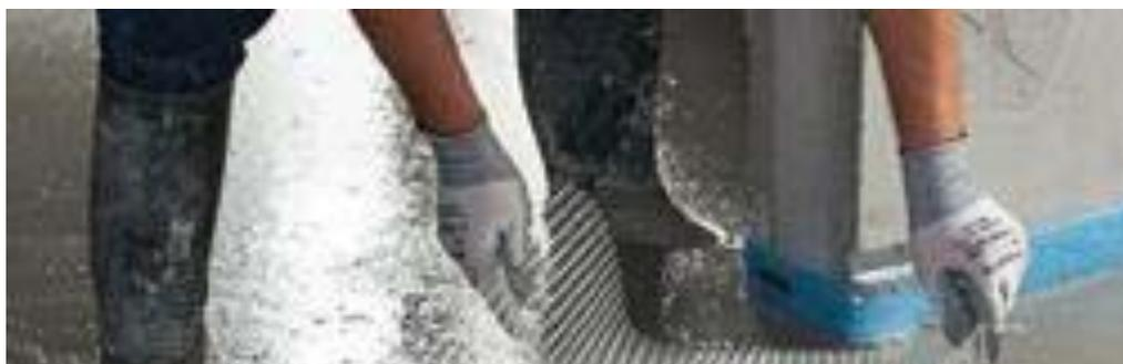
**Figure 1 - Pose d'un renfort d'angle**
