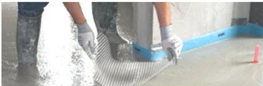
**Figure 1 - Pose d'un renfort d'angle**
